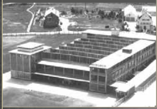
1955 Neubau der Elektroarmaturenfertigung Werk II.
