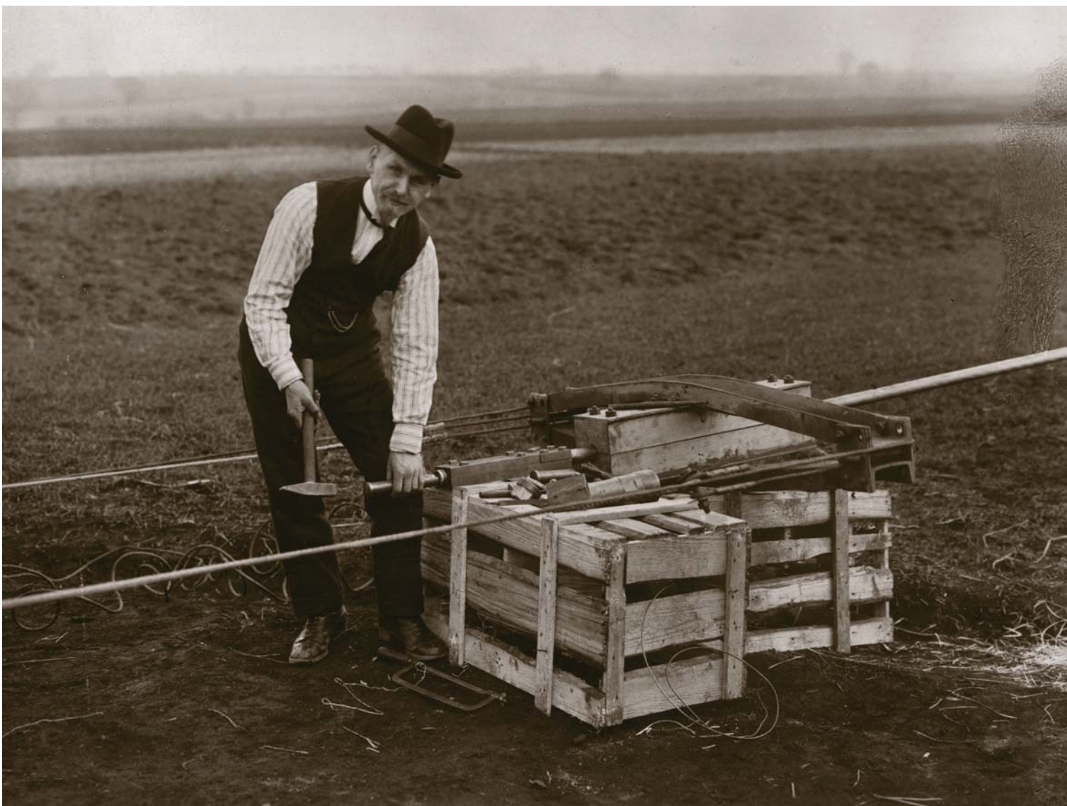
1926 Montage von Abspannklemmen durch Herrn Schemelli, der bis 1956 Haupt-Konstrukteur bei JWH und HAW war.
