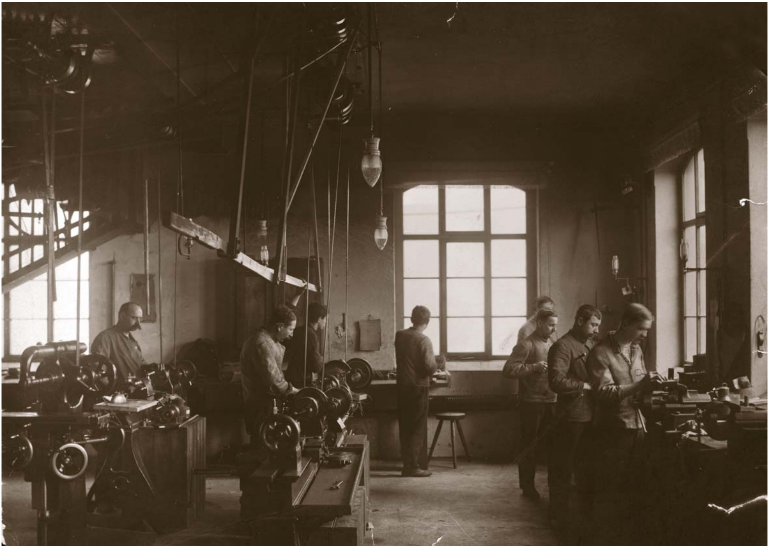
um 1912 Werkzeugschlosserei im ersten Werk an der Blücherstraße links: Drehbänke mit Transmissionsantrieb über Vorgelegewellen, die an der Decke befestigt waren. rechts: Arbeitstische mit Schraubstöcken
