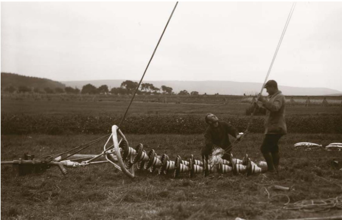
Die Doppel-Isolatoren-Kette wird für die Montage vorbereitet
