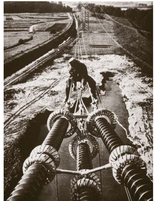
Abspannkette bei Koblach an einer 220/380 kV Leitung, 1953
