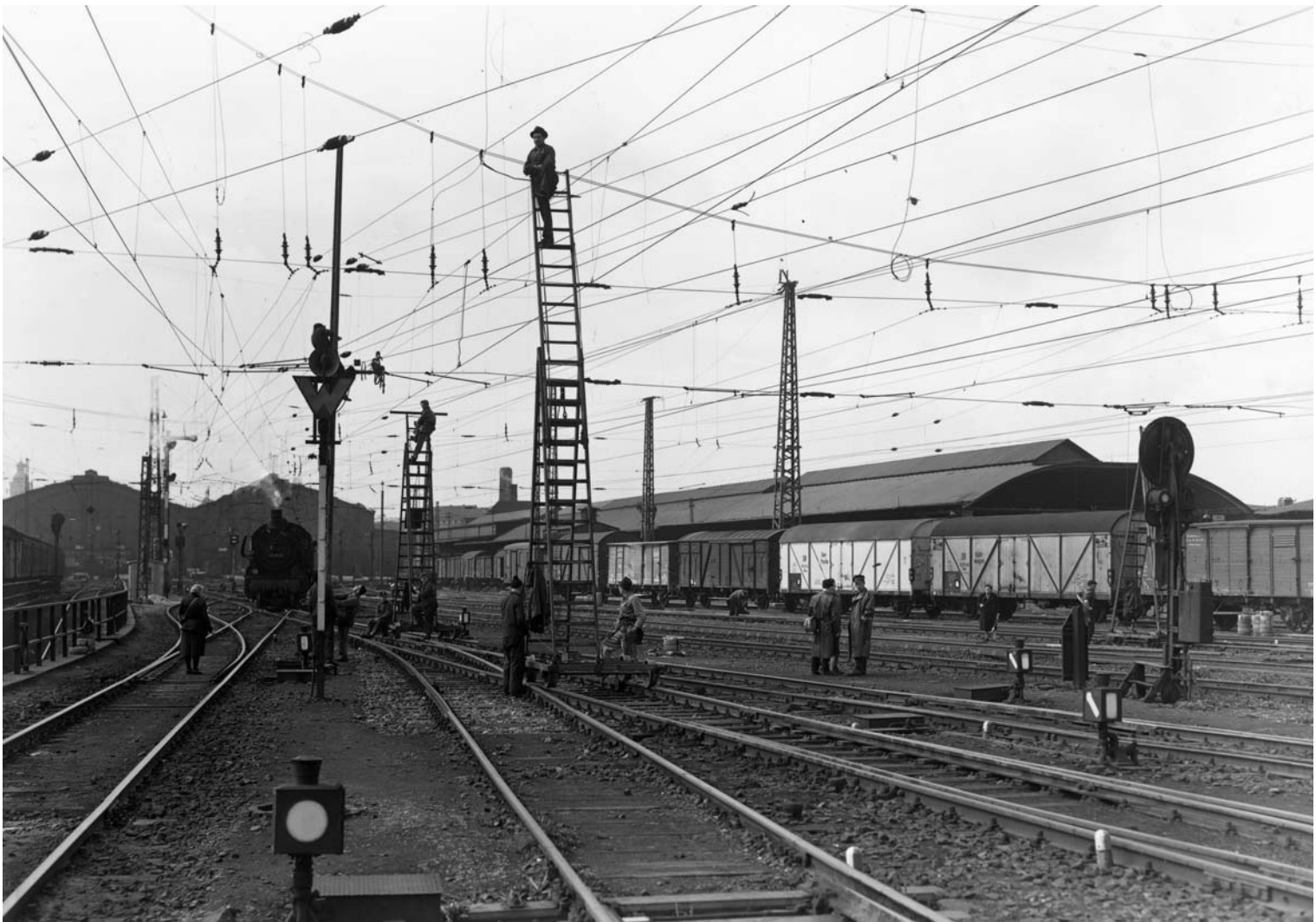
um 1965 Montage von Reichsbahn-Fahrleitungen mit Armaturen der HWA-Radebeul
