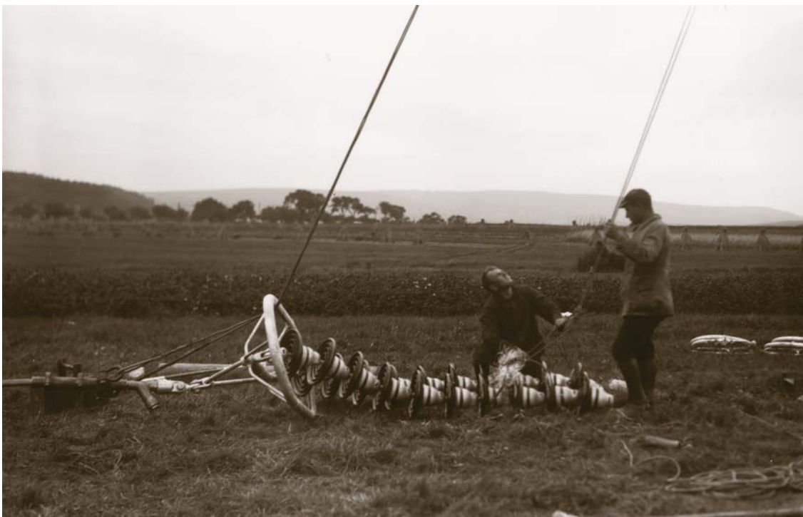
Die Doppel-Isolatoren-Kette wird für die Montage vorbereitet
