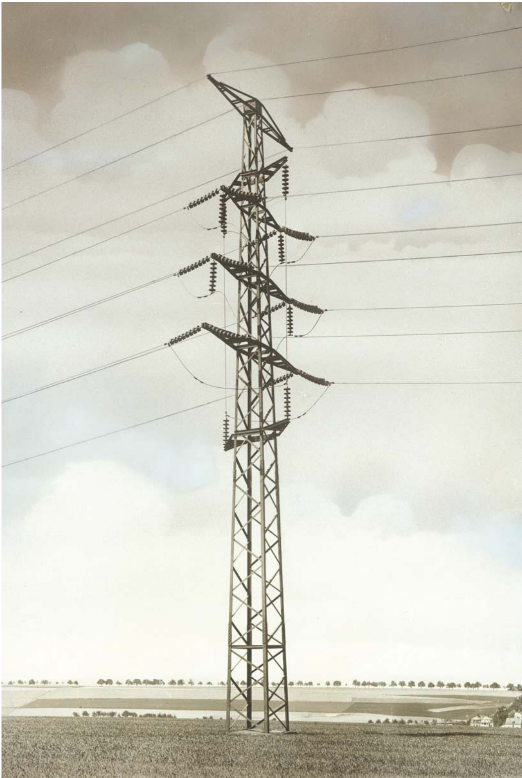
um 1920 110 KV-Verdrillingsmast (Abspann- mast) mit Isolatorenketten aus Kap- pen-Isolatoren und JWH-Armaturen
