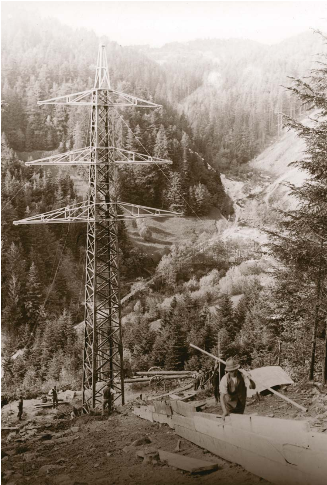
um 1910 110 KV-Freileitung von Partenstein nach Alkoven hier: Eckmast Nr. 2 im Bau
